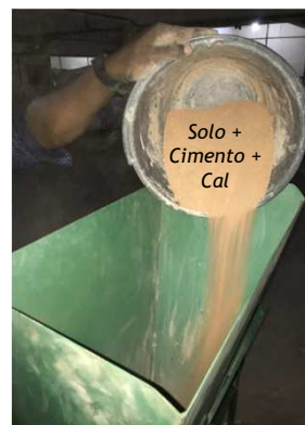
Abastecimento do silo.
