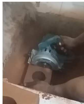
Corte do tijolo ao meio.
